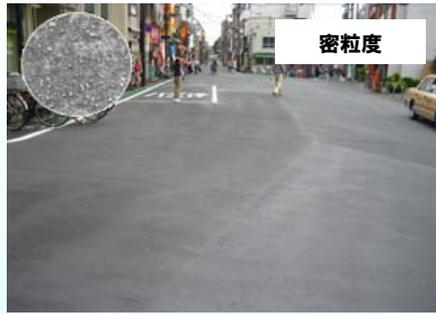
サーモテック工法は、低臭タイプの二液硬化型の反応性乳剤を使用した塗布（散布）型の遮熱性舗装で**昼間の舗装路面を最大10℃低減**することができます。
